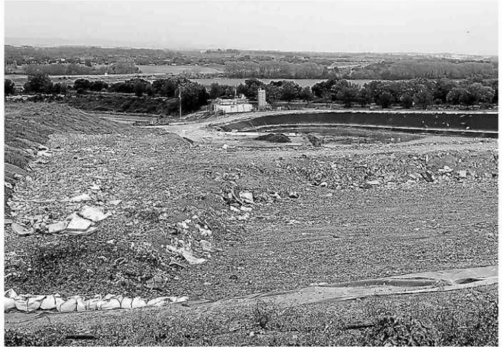
L'autorisation de l'ISDND de Saint-Jean-de-Libron à Béziers court jusqu'en 2029.
